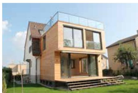
Über dem Zürichsee schweben die vormontierten EcoCocon-Elemente für die Obergeschoss-Ostfassade (oben) des Anbaus in Kirchberg, der von Petra Eggenberger mit hinterlüfteter Fassade geplant wurde (unten) Ansicht von Norden. Bilder:zvz
