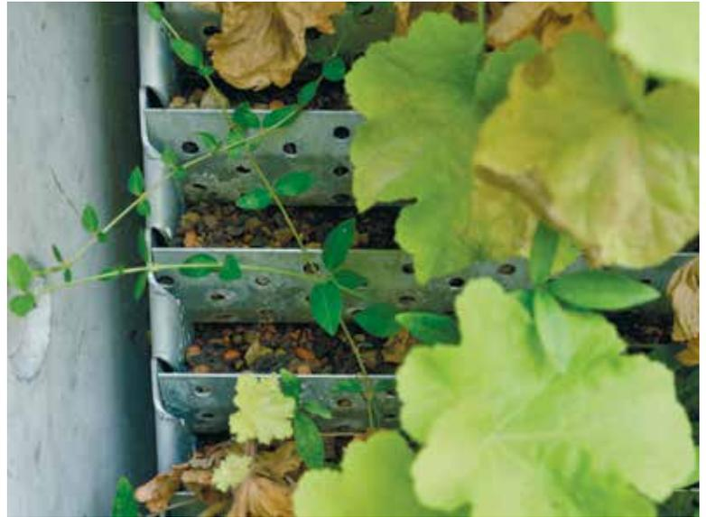
Detail der Fassadenbegrünung am PostParc in Bern: vertikale Stahlleisten mit mineralischem Substrat von Forster Baugrün. Foto:chr
