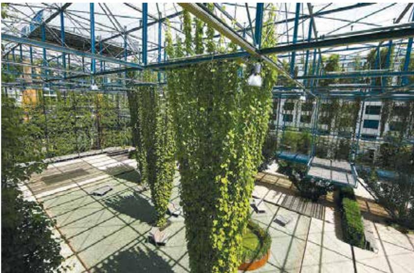
Kletterpflanzen am Stahlgerüst des MFO-Parks in Zürich Oerlikon. Das Stahlgerüst mit Jakob-Seilen und Forster Begrünung umreißt das Volumen der Halle, in der einst die Maschinenfabrik Oerlikon ihre Loks herstellte. Foto:zvg
