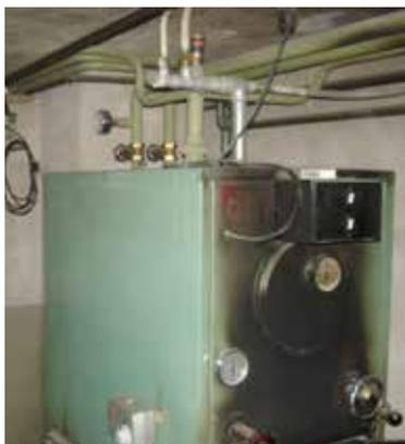
Zum Ersatz der alten Heizung (oben), sollte unbedingt auch Heizungsraum gedämmt werden (rechts), damit die Abwärme der Heizanlagen nicht verpufft. Fotos: zvg
