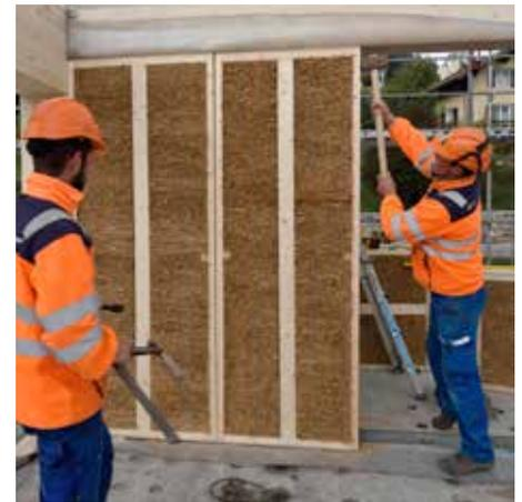
Montage der ersten zwei von insgesamt 48 EcoCocon-Strohfasaden-Elemente auf dem ersten Obergeschoss. Fotos: chr
